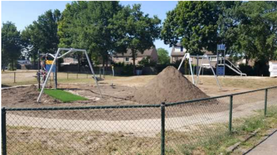
Situatie tijdens de plaatsing van de speeltoestellen
