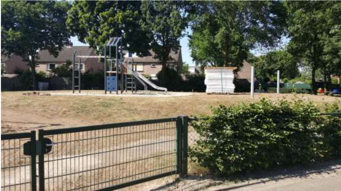
Situatie tijdens de plaatsing van de speeltoestellen
